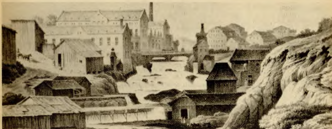
To store industrieanlegg ved Akerselva midt i forrige århundre. Nedre Vøien Spinneri fra 1845, og Hjula Veveri fra 1855. På 1850-tallet kjøpte Knud Graah spinneriet av grunnleggerne. Graah var en representant for det nye framvoksende industriborgerskapet i Norge. Artikkelforfatterne spør hvorfor den industrielle revolusjonen nådde Norge, men ikke landa i den nåværende tredje verden.
