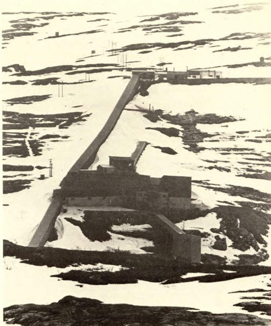
Gruveinngangen til Skorovatn gruver øverst på bildet. På midten ser vi flotasjonsanlegget.
