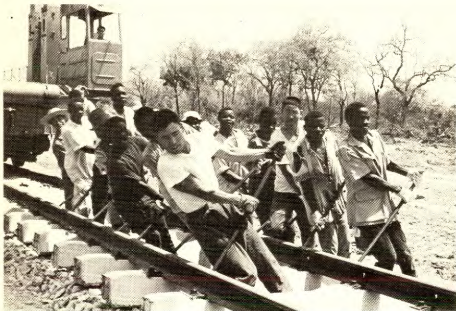
Byggingen av jernbanen mellom Tanzania og Zambia er et strålende eksempel på Kinas uselviske hjelp til land i den 3. verden.
